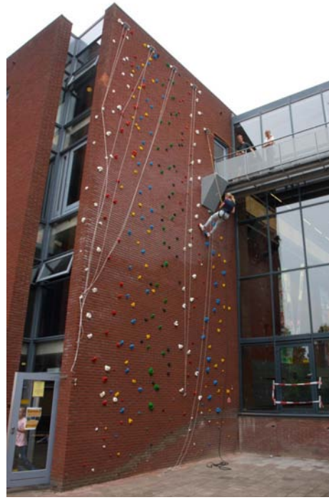
klimmuur aan school
