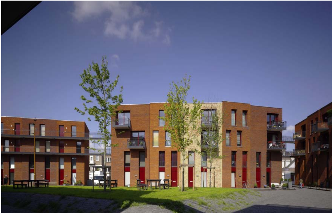
Figuur 28 Mecanoo architecten, residential St. Josephhof, Nijmegen, NL
